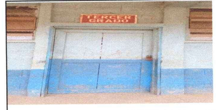
Foto 6: Sustitucion de puertas a metal y sustitucion de Vidrios.
