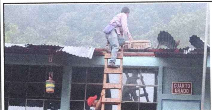
Foto 5: sutitucion de laminas, por laminas troquelada aluzinc y mantenimiento de costaneras.
