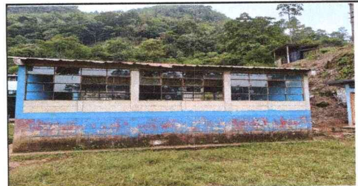
Foto 4: Modulo 2; sustitucion de Vidrios y mantenimientos .
