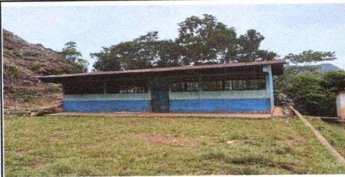
Foto 1: Modulo 1; sustitucion de láminas, por laminas troqueladas aluzinc
