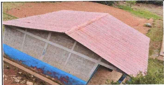
Foto 3: Modulo 2, sustitucion de laminas, por laminas troqueladas aluzinc
